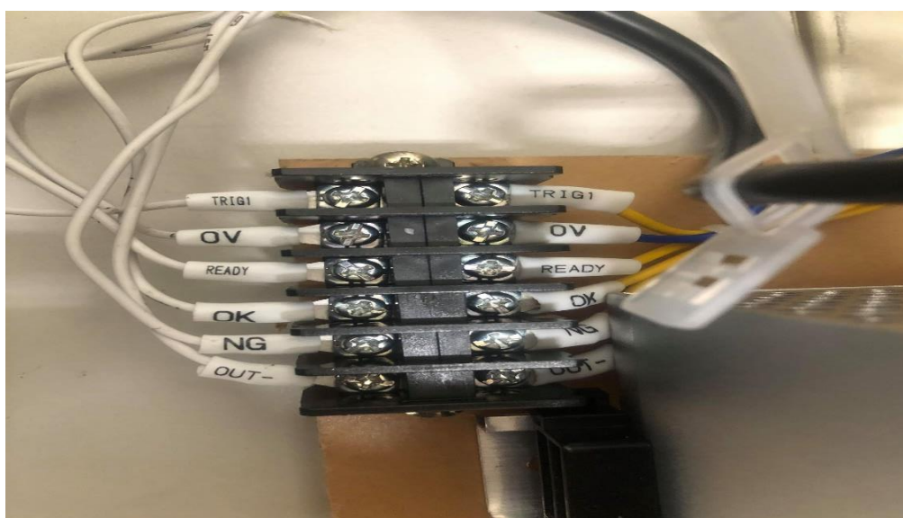
圖 6-7 台達系統輸出入接點
