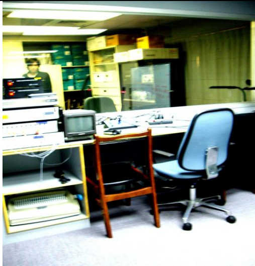
●教室內的中央控制室。輔大對於機器位置的安排與師大很不相同，這是一間獨立的房間，且臨近口譯員隔間室，主控教室內麥克風音量、音調等設備。
